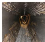
Bestehender Kanal mit nachträglich eingebauter Wärmerückgewinnung
