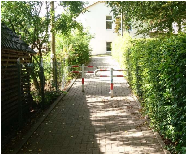
Umlaufsperrre (vgl. Maßnahme H6)
